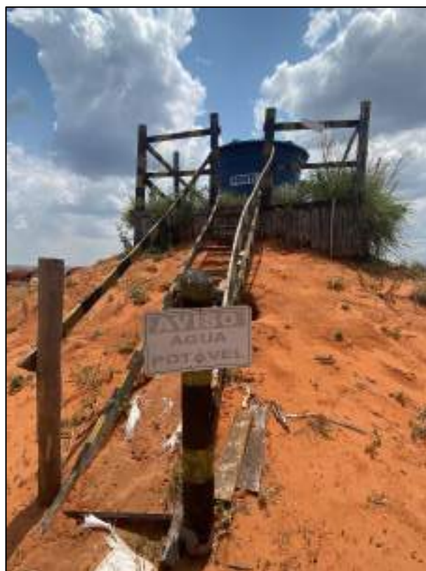
Foto: Escada que dava acesso à plataforma onde ficavam as caixas d'água. Faltavam degraus e não havia guarda-corpo suficientemente capaz de proteger contra quedas.
