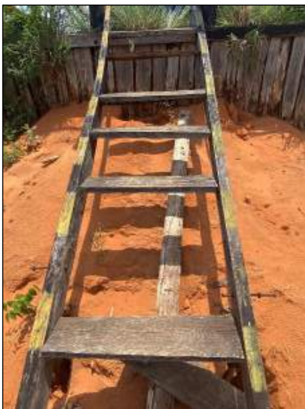
Foto: Escada que dava acesso à plataforma onde ficavam as caixas d'água. Faltavam degraus e não havia guarda-corpo suficientemente capaz de proteger contra quedas.
